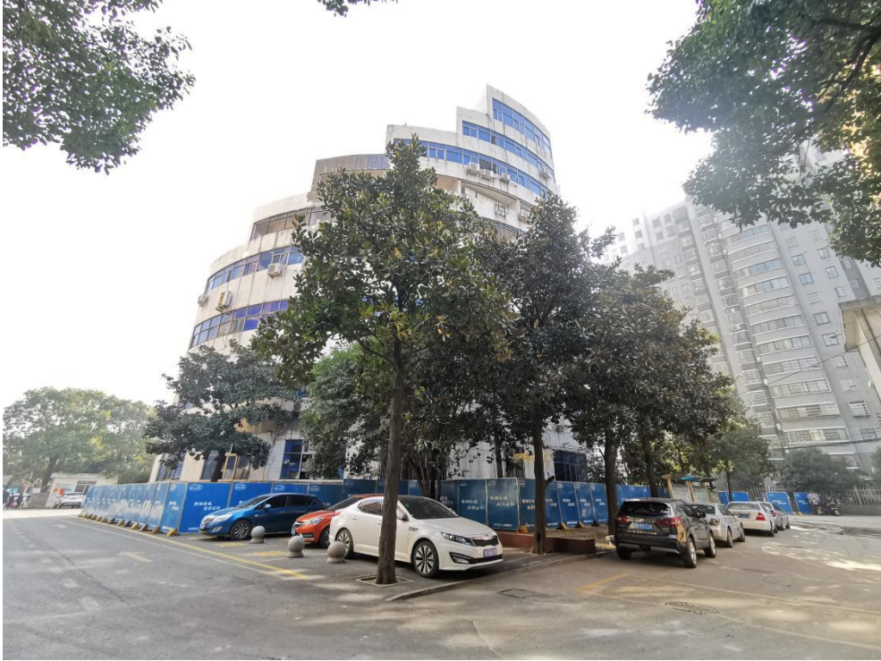
综合办公楼西侧现状图（图 1）
