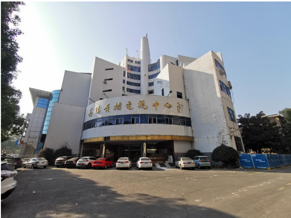
综合办公楼北侧现状图
