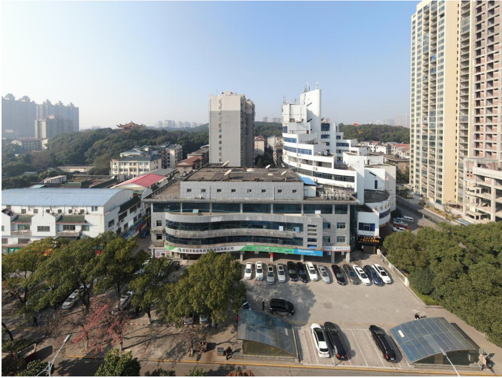
综合办公楼现场全景图
