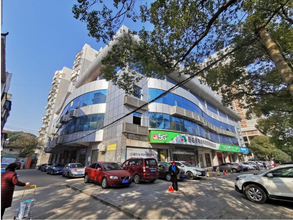
综合办公楼南侧现状图
