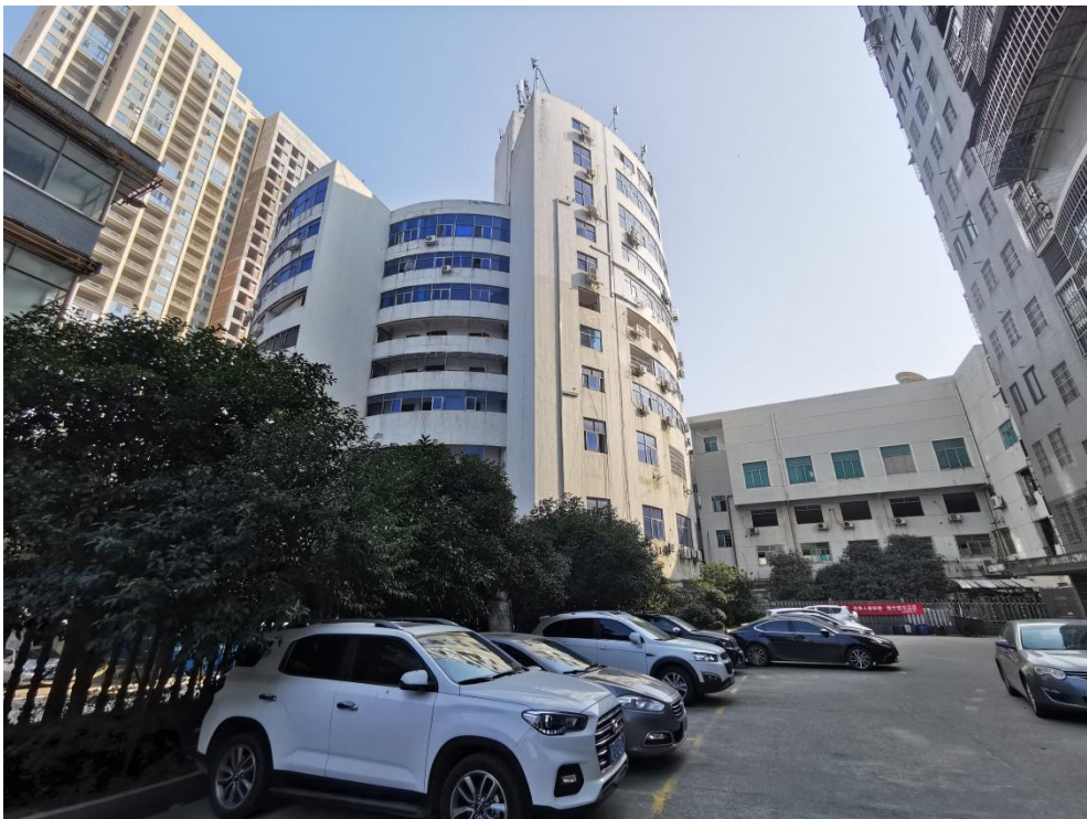
综合办公楼西侧现状图（图 2）
